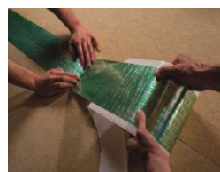
Lorsque le primer est translucide, dérouler la bande en enlevant le papier de protection et la presser à la main afin de la tendre et d'éviter les plis
